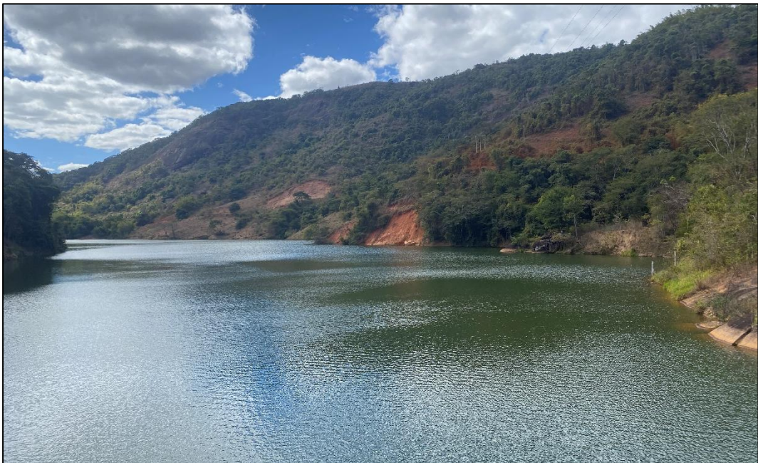
Figura 5.2 - Margem esquerda do reservatório da PCH Senhora do Porto.
