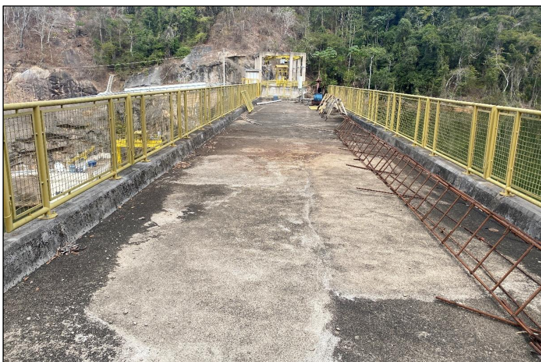
Figura 5-2 – Crista pela margem esquerda do reservatório da PCH Jacaré
