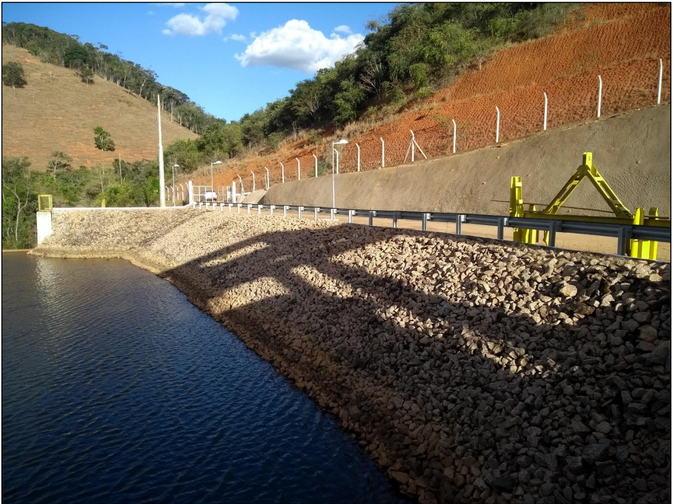
Figura 5.1 - Margem direita do reservatório da PCH Fortuna II.
