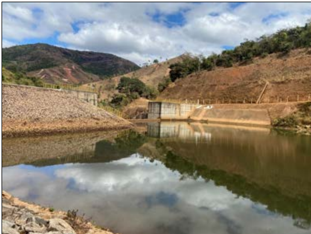
Figura 5-3 – Margem esquerda de terra e margem direita de concreto da Sistema extravasor da PCH Dores de Guanhões.
