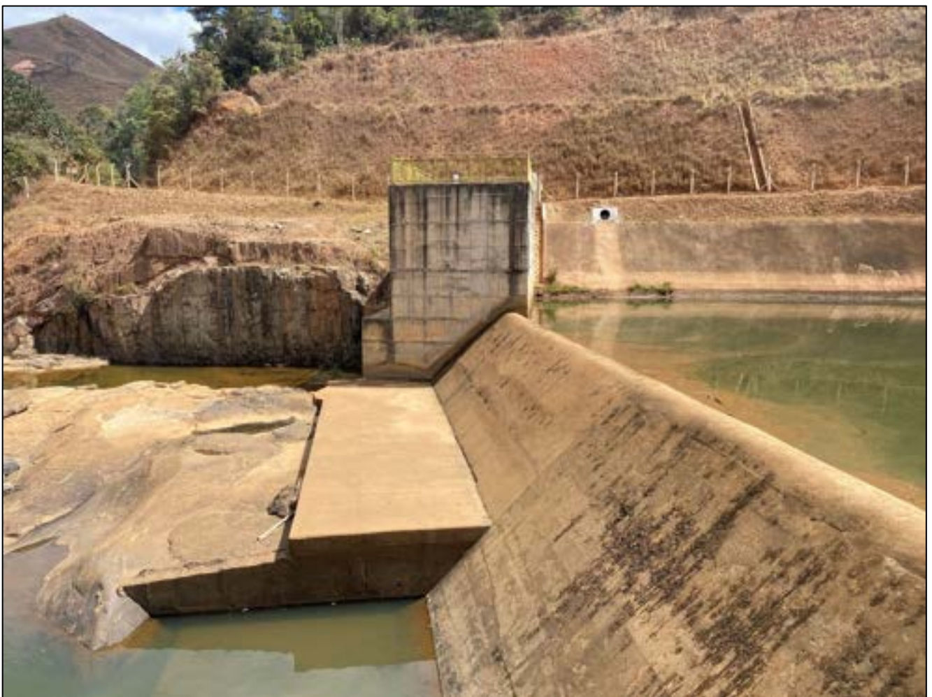
Figura 5-1 - Margem direita do reservatório da PCH Dores de Guanhões e sistema extravasor.
